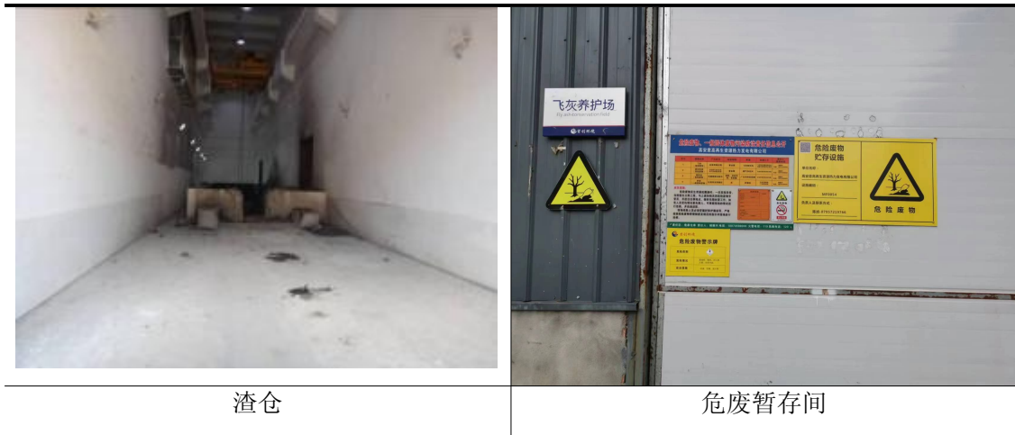
图 3.1-8 固体废物暂存场所
