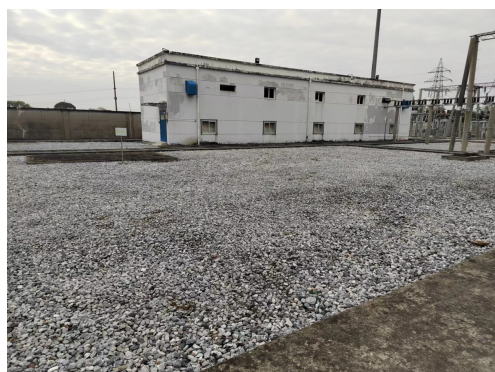
拟扩建 2#主变位置
