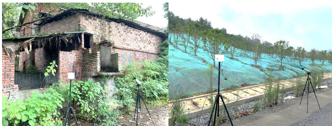
图2-1 现场监测照片
